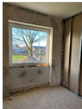
8B I dette lejemål er tømmerne i gang med at sætte gipsskillevæg op.
