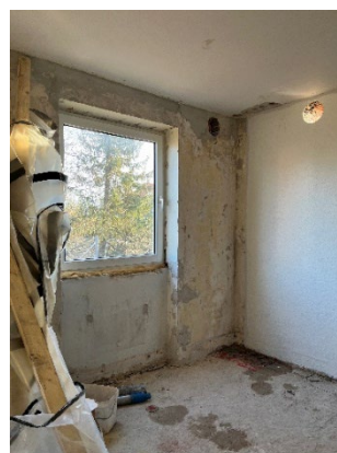
8B Der er sat savsmuldstapet op og boret ud for ventilationsrør.
